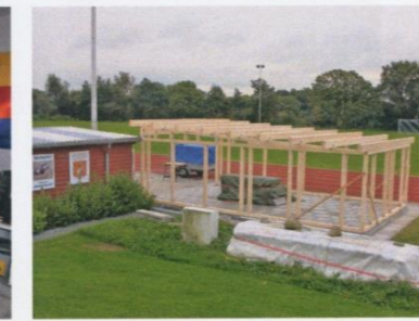
10.10.2016 Das Ständerwerk geht seiner Vollendung entgegen.
