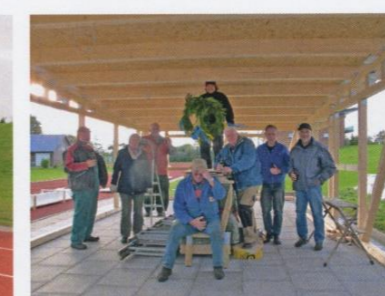
13.10.2016 Ein kleines Richtfest und ein kleines Bier zur Feier des Tages.
