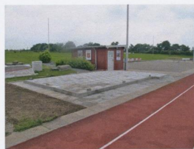
27.06.2016 Beginn Neubau der neuen Terrasse. Bodenplatte wird gelegt.
