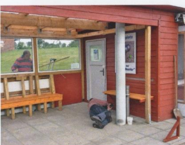
19.06.2016 Abriß der alten Terrasse unter erschwerten Bedingungen.
